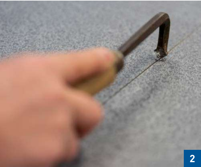
Rainurage avant soudure
