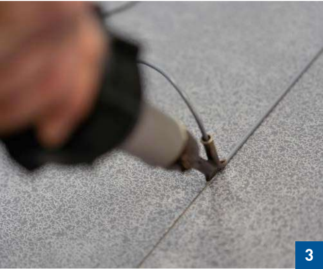
Soudure à chaud des cordons
