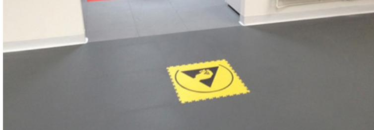
Possibilité d'emboîter des dalles **MODULE PRINT** pour schématiser les zones de danger mais les dalles **MODULE PRINT** ne seront pas conductrice.
